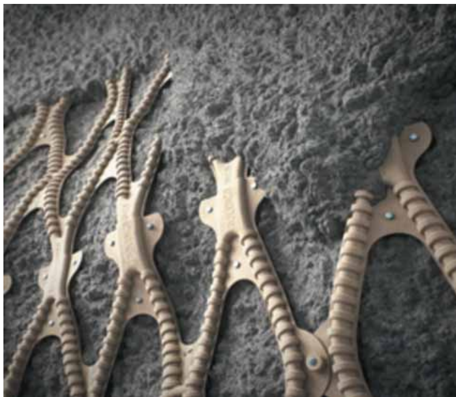
Рис. 2. Установленный элемент дренажной сетки Dolenco
